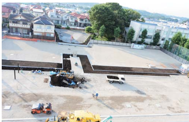
2023年7月10日現在の駐車場工事進行状況
